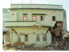
भवन के कुछ हिस्सों का ढहना
