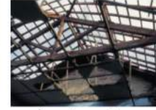
छत के खपरैल का खिसकना
