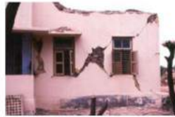
भवन के छत का गिरना
