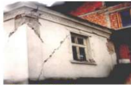
Actual EQ Damage
